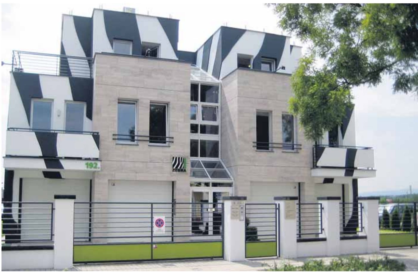
Terra Zebra Lakópark, Budapest XVI. A Fenstherm által épített otthonok visszatükrözik a kerület jellegzetesen elegáns nagypolgári hangulatát
